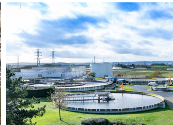
Usine de traitement des eaux usées Suez
