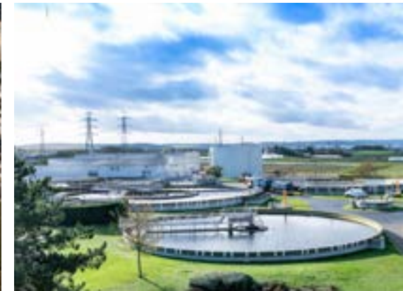
Usine de traitement des eaux usées Suez
